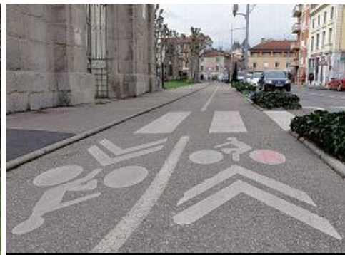
DU CÔTÉ DE MONTRISON. Ci-dessus, la chaussée à voie centrale banalisée de la route de Champdieu à Montbrison. Un aménagement similaire est en projet sur la rue du Champ de mars à Savigneux.
